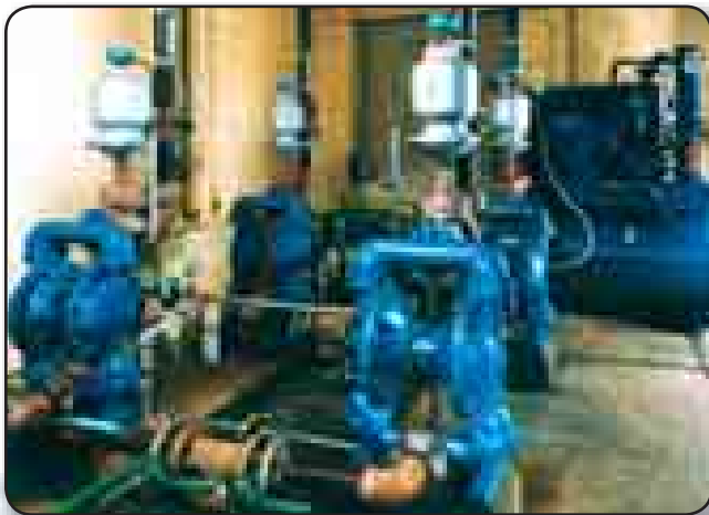
Постоянно установленные металлические насосы обычного режима в системе отбора проб на химическом предприятии.
