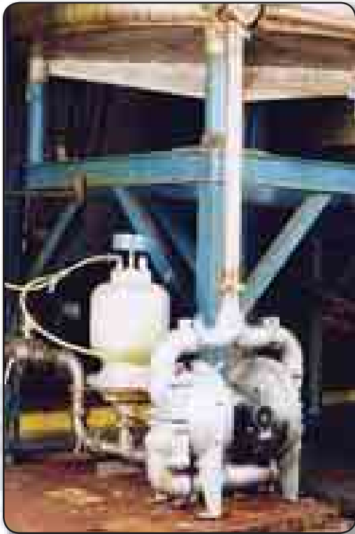
Насос тяжелого режима с откидными клапанами, установленный для откачки отстоя.
