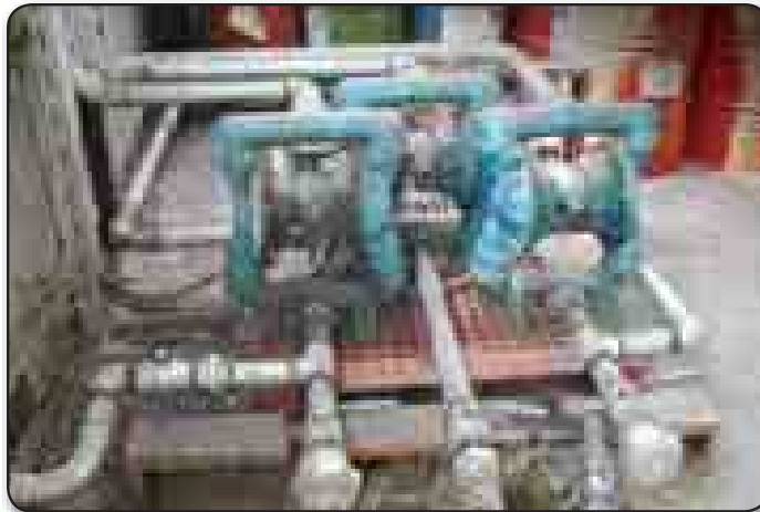
Металлические насосы стандартного режима на откачке отстоя из наружных колодцев.
