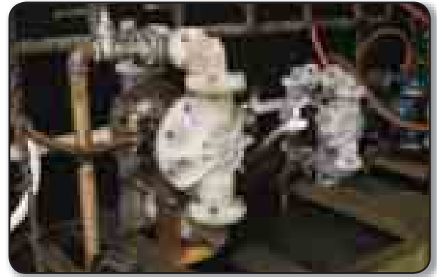
Полипропиленовые насосы обычного режима на химическом предприятии.
